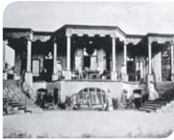
Das Sanatorium auf dem Monte Verità
